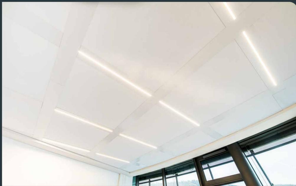
Mineralklimadecke mit integrierter Beleuchtung
