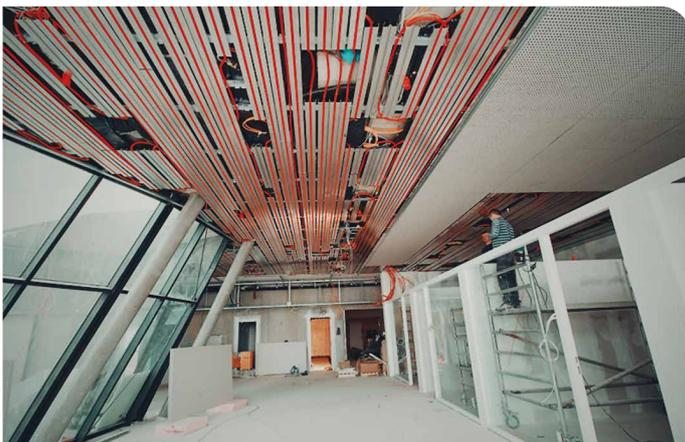
Die abgehängte Klimadecke für die **WU-WIEN** wurde vor Ort präzise auf die komplexe Geometrie der Decke zugeschnitten und erzielt so eine Belegungsdichte, die mit vorgefertigten Kassetten nicht möglich wäre.
