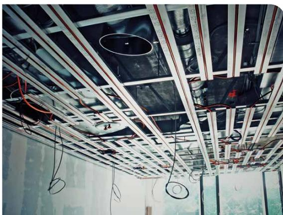
Über der abgehängten Klimadecke des **RBZ BIBERACH** ist genug Raum für Lüftungskanäle und andere Elemente der Haustechnik.
