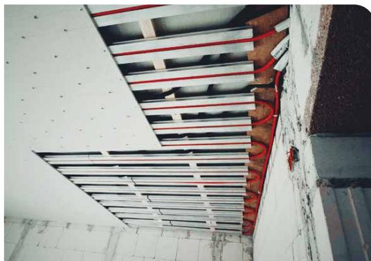
Die Wärmeleitprofile sind hier auf eine Konterlattung montiert. Rohre werden einfach in die Sicke der Profile gedrückt.
