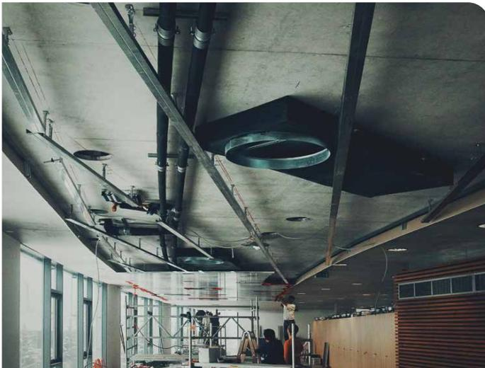
Im Vordergrund sieht man die abgehängten Tragprofile für die entstehende Klimadecke der **ROMA KG**. Im Hintergrund sind darauf bereits Wärmeleitprofile montiert und Rohre in deren Sicke befestigt.
