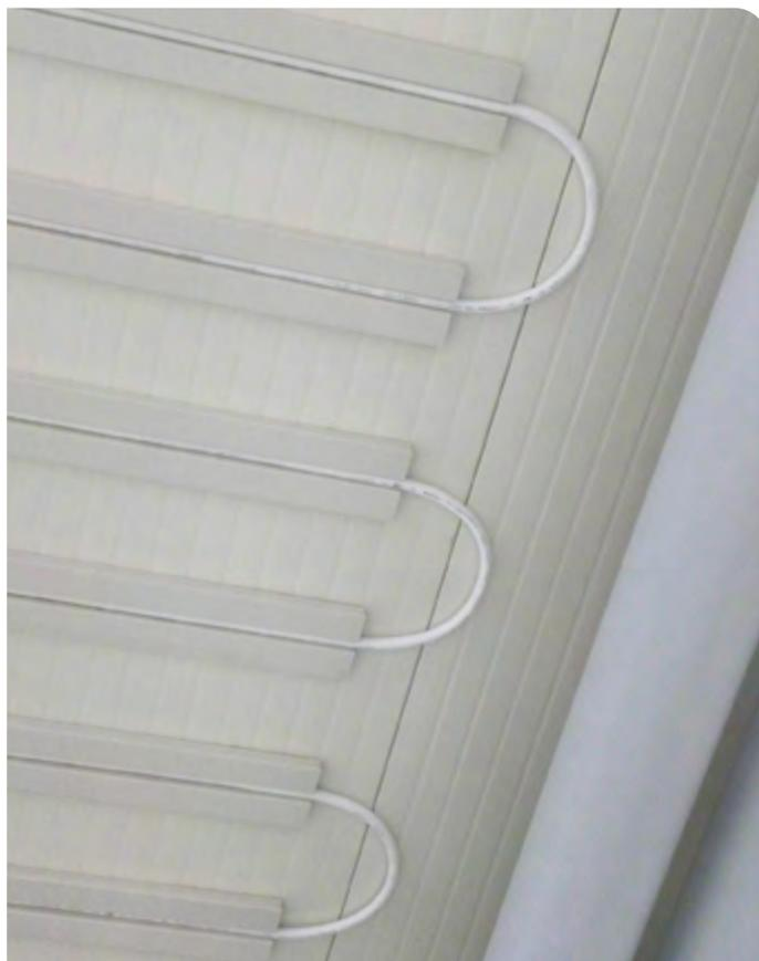
**Im Rekordsommer 2015 mit tagelangen Temperaturen über 35 °C erzielte das System mit durchschnittlich 15 °C Vorlauftemperatur eine operative Temperatur von 26 °C im gesamten Gebäude. Raum-K Systeme sind somit eine gute Investition in Anbetracht der zukünftigen starken klimatischen Schwankungen.**
