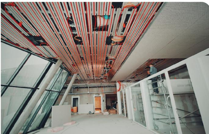
Die abgehängte Klimadecke für die **WU-WIEN** wurde vor Ort präzise auf die komplexe Geometrie der Decke zugeschnitten und erzielt so eine Belegungsichte, die mit vorgefertigten Kassetten nicht möglich wäre.
