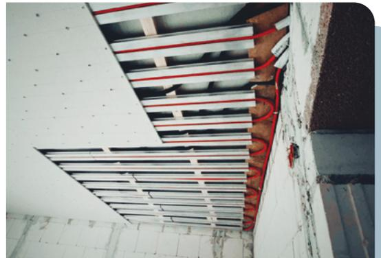
Die Wärmeleitprofile sind hier auf eine Konterlattung montiert. Rohre werden einfach in die Sicke der Profile gedrückt.
