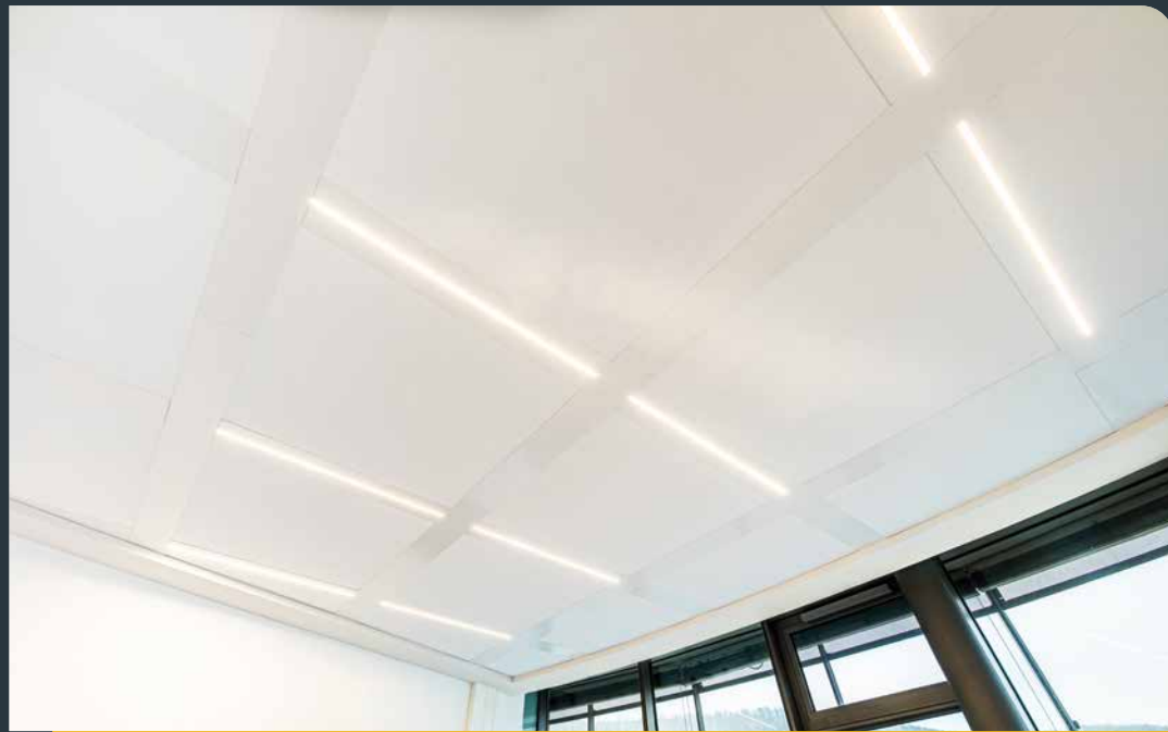
Klimadecke mit integrierter Beleuchtung
